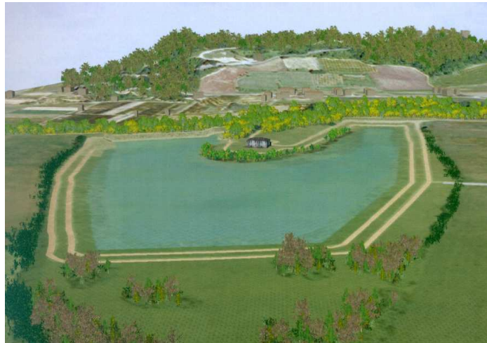
Rendering di una cassa di espansione realizzata in Provincia di Forlì-Cesena in un’area destinata ad attività estrattiva grazie ad un partenariato pubblico privato
