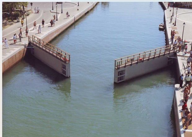
Le Porte Vinciane di Cesenatico, un esempio di misura di mitigazione strutturale
